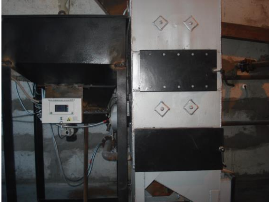
Рисунок 1 - Внешний вид котла со шнековой подачи на 300 кВт. Установлен на ТОО «Рapid»
