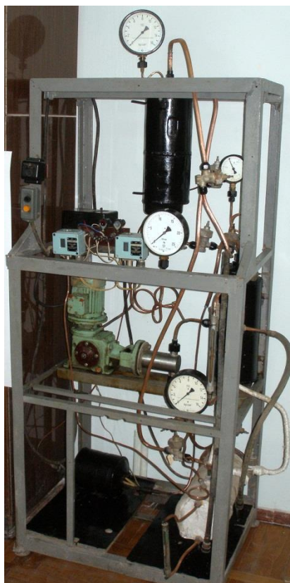
Рисунок 1.5 -. Установка для очистки внутренних полостей агрегатов сплит-систем
